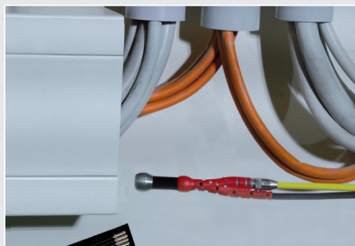
Schächte und Unterflurkanäle
